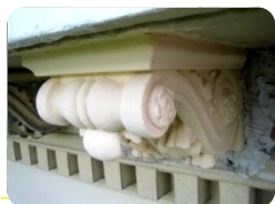
Stav po rekonstrukci:
