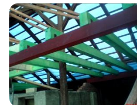
Stavba podkroví BD: Rotalova 36 v Brně: Stavba podkroví včetně krovů, ocelových konstrukcí a krytiny. Cena: cca. 1.300.000,00Kč Investor: Ing. Osvald
