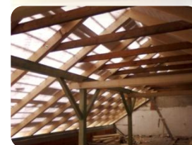
Nová střecha KO Špitálka 8 v Brně: Montáž nového krovu a střechy. Cena: cca. 510.000,00Kč Investor: Lídero s.r.o..
