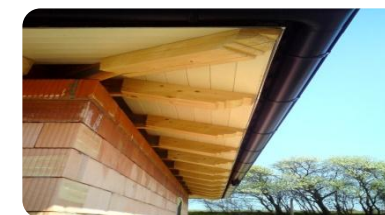
Vyřezávané ukončení krovů.
