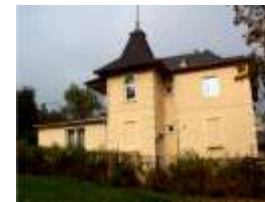
Zateplení RD Veslařská v Brně
