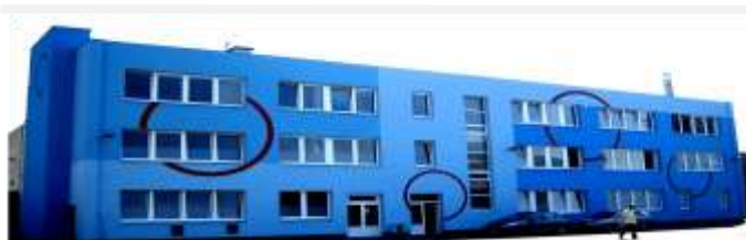
Zateplení objektu fa. Kamoko, Brno - Modřice Výměra: 650m 2 , Systém: Ceretherm Premium, Cena: 1.150.000,00Kč Investor: Kamoko s.r.o., Provedení včetně Tizn. oplechování.
